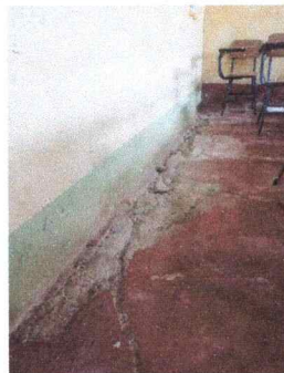
Foto 2: Colocación de piso cerámico Aula 3.
