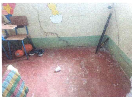
Foto 3: Colocación de piso cerámico Aula 4.
