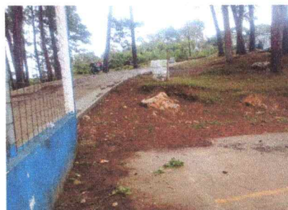
Foto 6: Construcción del Portón Principal
