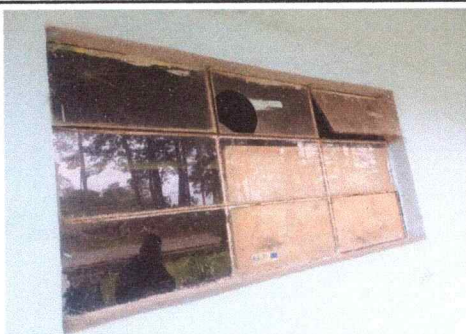
Foto 5: Cambio de ventana aula 3, aula 4
